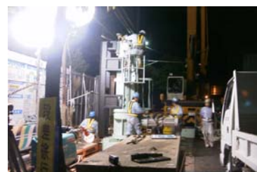
夜間不断水せん孔施工状況
