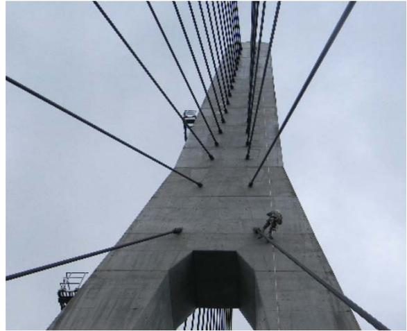
【斜張橋主塔 H=65m のロープワークによる点検】
